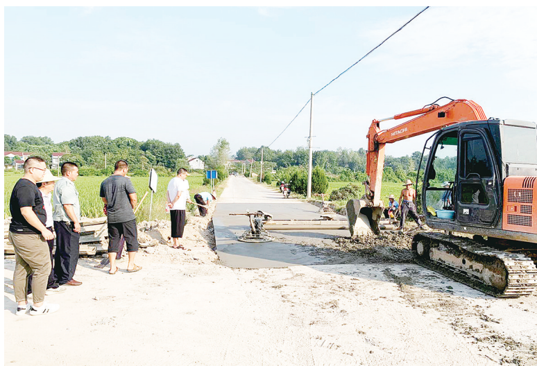
9月14日下午，怀宁县腊市镇组织专业工人和大型机械对破损路面进行修补。
