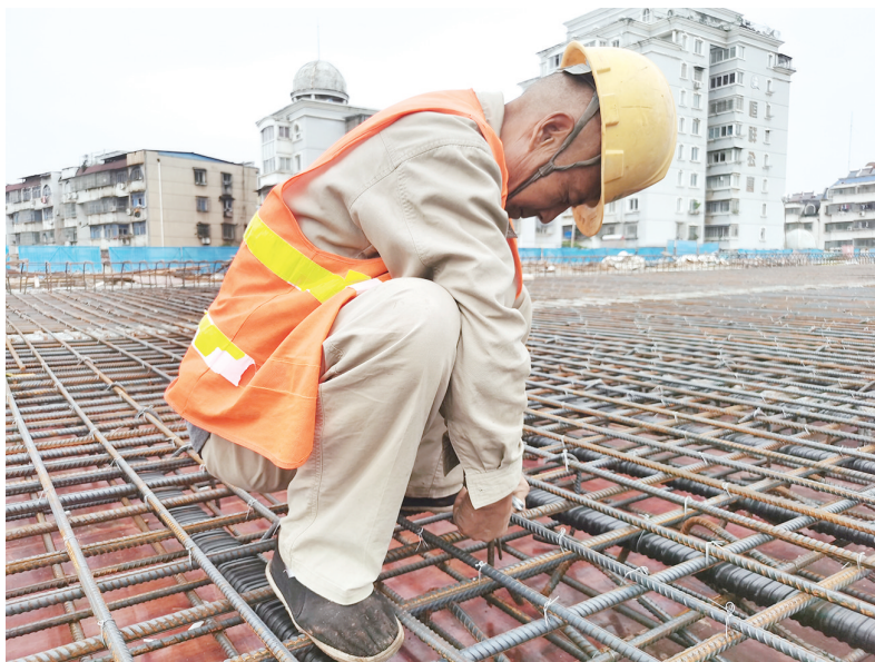
10月6日上午,任振社在中兴大街的高架桥面上进行钢筋绑扎。
