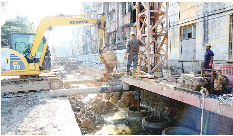
11月9日,大观区戏校河菱湖段正在进行机械深挖清淤施工作业。戏校河治理工程全长1.64公里,总投资3400万元。计划明年4月前完成。
