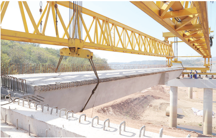
图为勇进路头坡湖大桥首片梁顺利架设。
