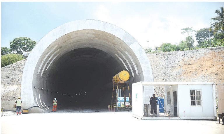
这是11月15日在印度尼西亚西爪哇省拍摄的雅万高铁7号隧道。
