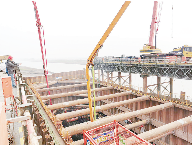
工人们正在进行桥梁主墩承台浇筑。 全媒体记者 项珍 摄
