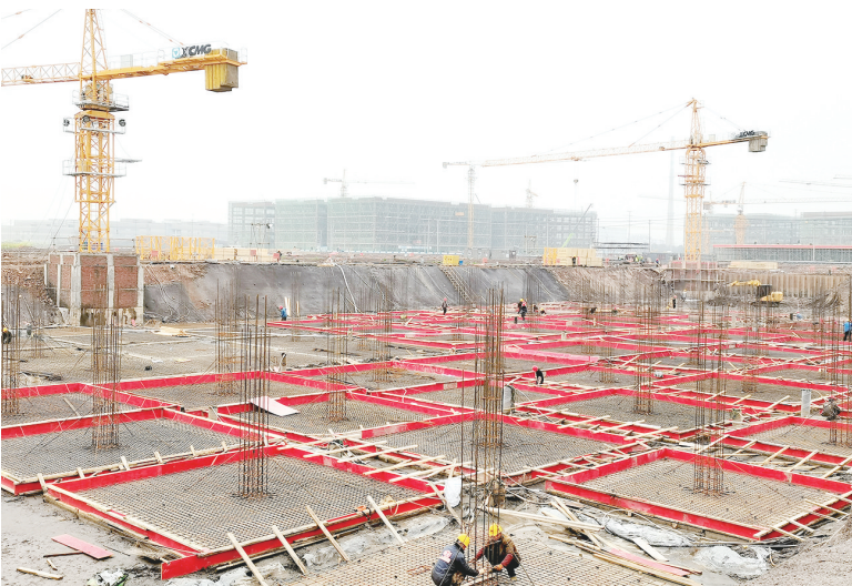
图为3月21日,位于望江县经济开发区的中国(望江)纺织服装产业新城项目建设现场。
