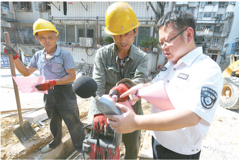
环境监察执法人员对工地施工人员进行中高考禁噪宣传。 全媒体记者 黄有安 通讯员 项顺平 摄
