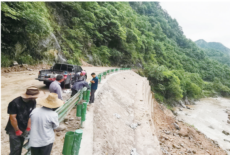
7月5日,国道105岳西县黄尾镇段,工人正在安装护栏。受持续暴雨影响,此处50米护栏被洪水冲垮,当地相关部门立即组织工人抢修,确保公路安全畅通。
