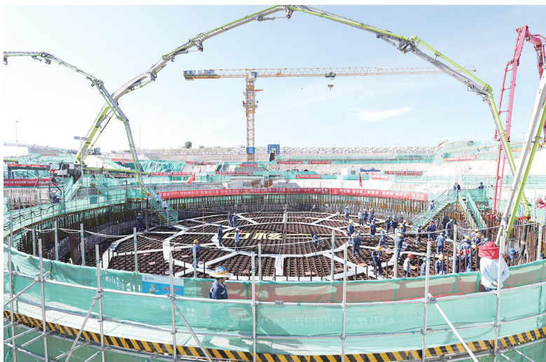
7月13日，工人在海南昌江“玲龙一号”施工现场工作。新华社发
