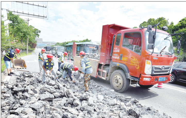
7月14日上午,在集贤北路、潜江路等处,市市政道路维修工人头顶着烈日抢修破损路面。 近期持续高温天气,市市政工程管理处在抢抓工期的同时安排工人错峰作业,共对城区90余条主干道进行排查维护,目前已完成道路维修面积6万余平方米。同时还开展道路积水点整治、井盖座换装专项整治项目,及时消除道路交通安全隐患,提升城市道路环境。 全媒体记者 黄有安 通讯员 程飞 摄
