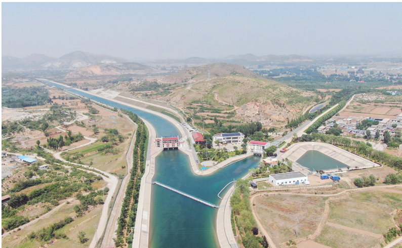
这是南水北调中线西黑山枢纽——南水从这里一分为二流往北京和天津(5月25日摄,无人机照片)。
