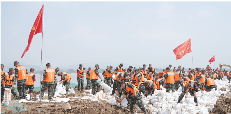
武警河南总队某支队官兵在新乡市卫河河堤上装填沙袋(7月24日摄)。
