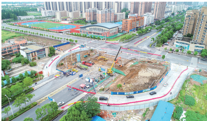
8月10日,文苑河水环境整治工程——皖江大道箱涵正在封闭施工。
