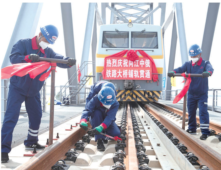
8月17日,工人在同江中俄黑龙江铁路大桥施工现场进行施工。 新华社发
