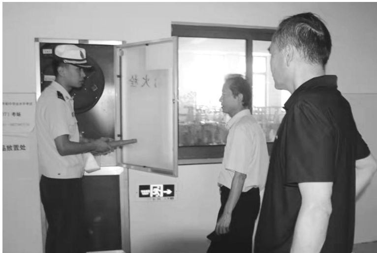
消防监督执法人员讲解消防器材维护保养方法。 彭玲玲 摄
