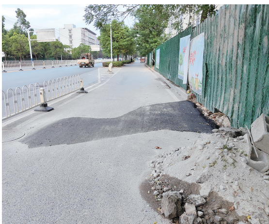
填补平整后的路面
