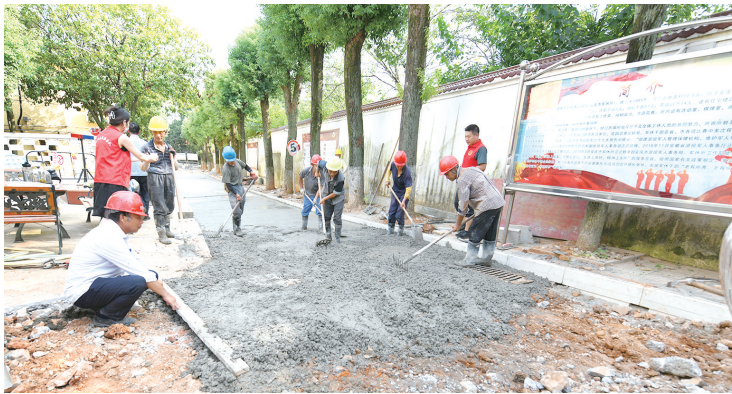
9月1日,安庆市军休所大院内,施工人员正翻修小区道路。安庆经开区将军休小区改造升级纳入民生工程,改造完成后将提升排水排污能力。 全媒体记者 曹有安 通讯员 崔燕 摄
