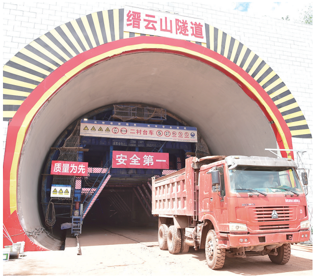
这是9月8日拍摄的渝昆高铁川渝段站前一标缙云山隧道施工作业现场。目前，由中铁十一局承建的渝昆高铁川渝段站前一标项目正在加紧施工，各项工程进展顺利。 新华社发
