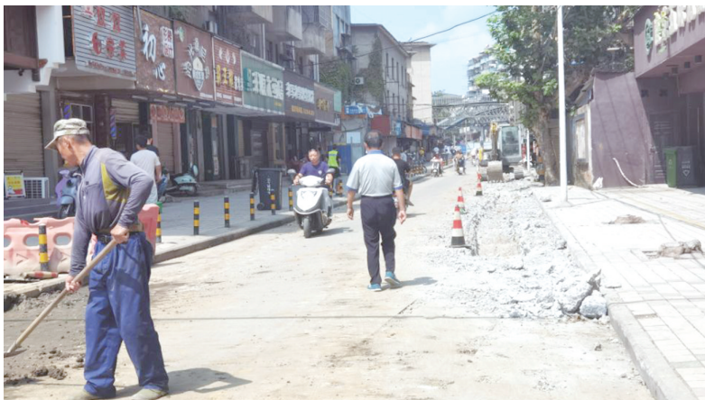
施工单位正在对路面进行施工。
