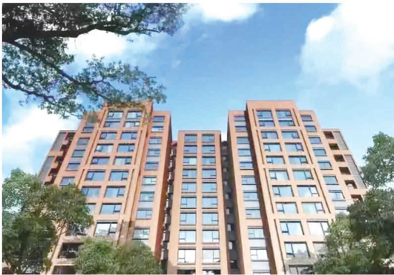
图为合肥开工建设的保障性棚改安居工程住房。（来源于网络）
