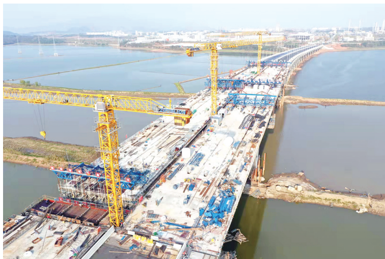
10月29日,建设中的勇进路大桥。全媒体记者 徐火炬 通讯员 陈嵩 摄
