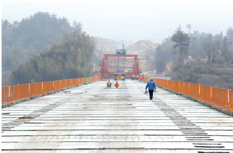
11月5日,在岳西县天堂镇境内,上海至武汉国家高速公路无为至岳西段项目现场一片繁忙,工人正有序作业。
