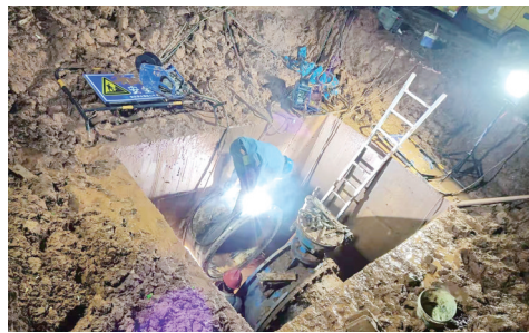
潘方平在一水厂门口抢修伸缩器。图片由本人提供
