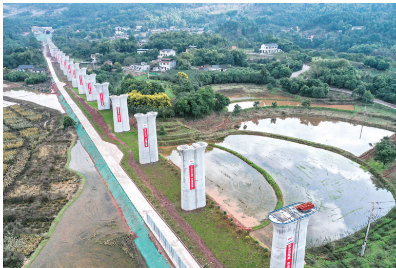
这是2月9日拍摄的建设中的渝昆高铁川渝段马家屋基特大桥施工段。春节过后，中铁十一局等渝昆高铁各参建单位加大投入、加速建设，力争线路早日建成通车。渝（重庆）昆（昆明）高铁是全国铁路“八纵八横”之一京昆通道的组成部分，全长699公里。 新华社发
