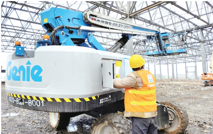
江淮年产10万辆新能源乘用车搬迁项目现场。 通讯员 方园 摄
