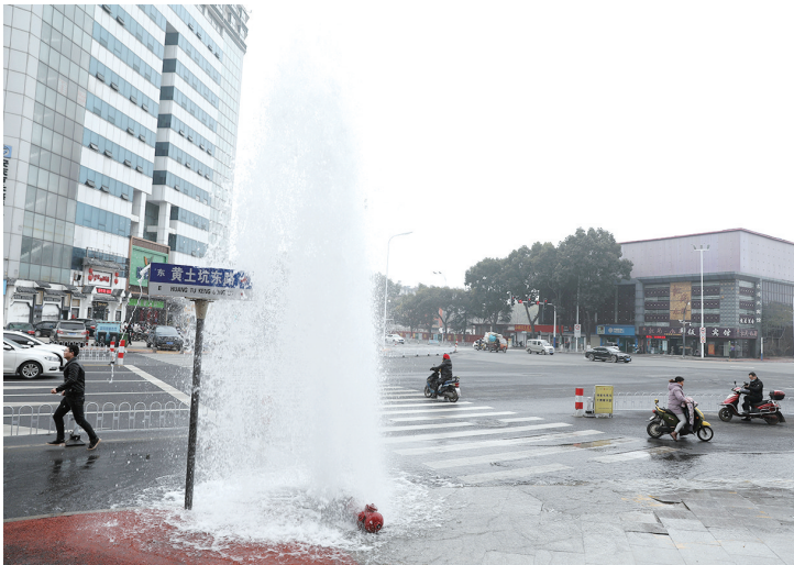
2月13日,黄土坑东路一消防栓因交通事故损坏,喷出七八米高的水柱。记者现场了解到,一辆电动自行车逆行导致对向的一辆三轮车紧急避让,从而不慎撞到了消防栓,约十几分钟后,供水集团工人紧急赶到将喷水的消防栓关闭。
