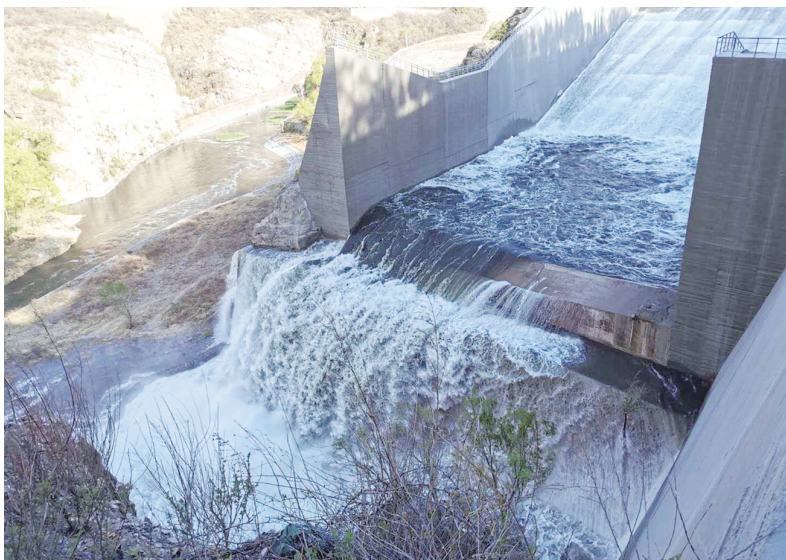
图为水库开闸放水，为永定河生态补水。（网络照片）
