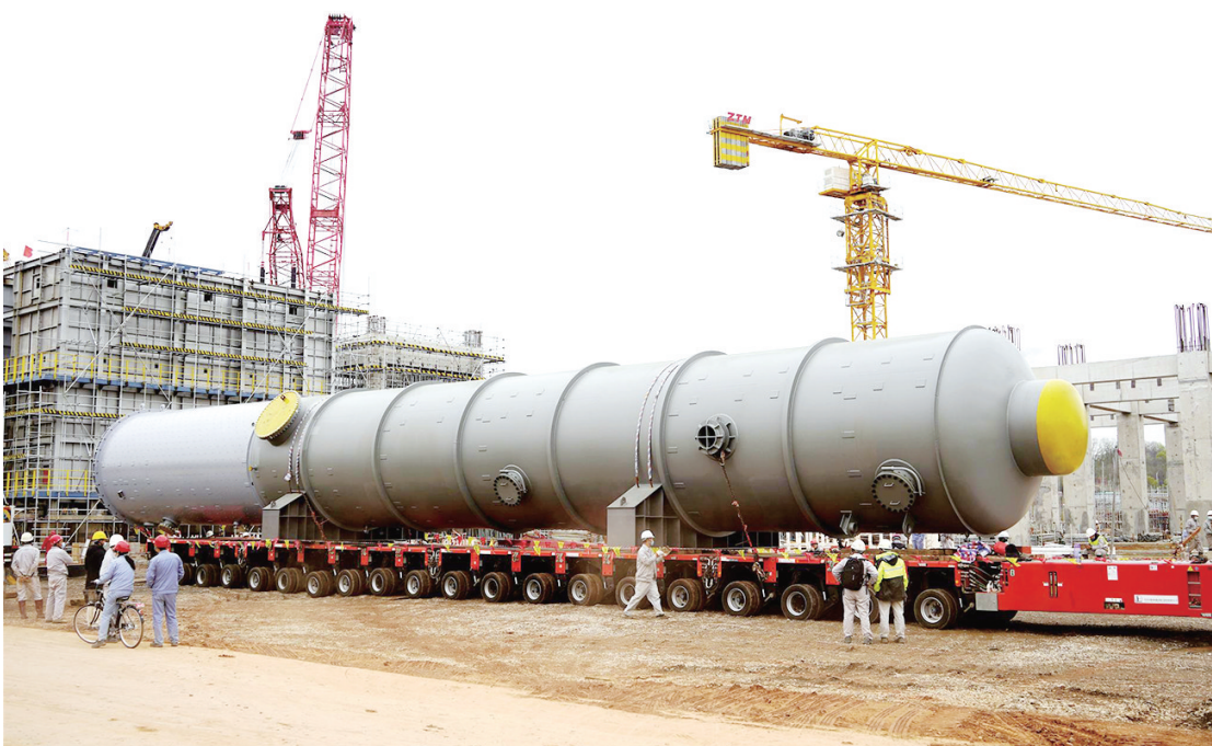
3月18日下午，安庆石化转型项目首台超限设备运抵施工现场。
