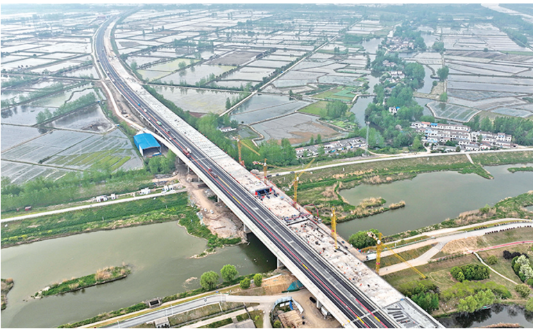
合宁高速改扩建工程省界滁河大桥合龙现场。
