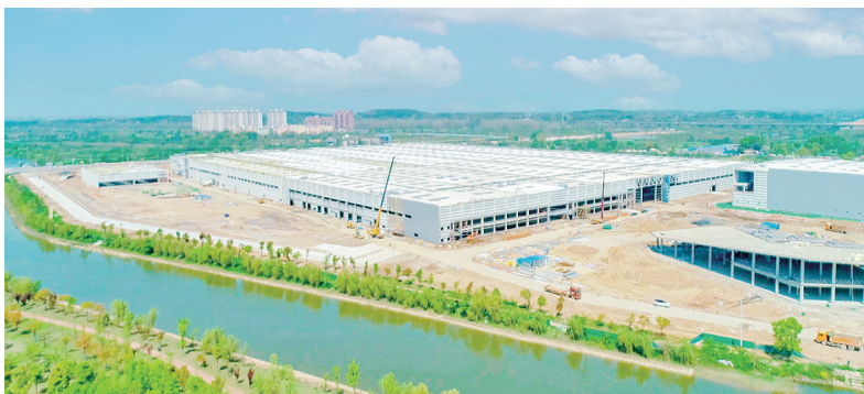
“五一”期间,江淮安庆年产10万辆乘用车(含新能源)搬迁项目现场,建设者们奋战在施工一线,开足马力,确保工程顺利推进。
