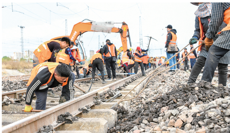
5月11日，中国铁路太原局集团有限公司大同工务段的工人在更换石砟。
