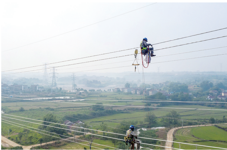
5月28日,电力工人在望江县太慈镇架设安徽安庆江调220千伏输变电工程线路。
