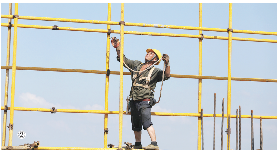
①水电工李秀勇半蹲着,在楼顶铺设水电管道。②架子工林南贵站在钢管上,头顶烈日搭设脚手架。
