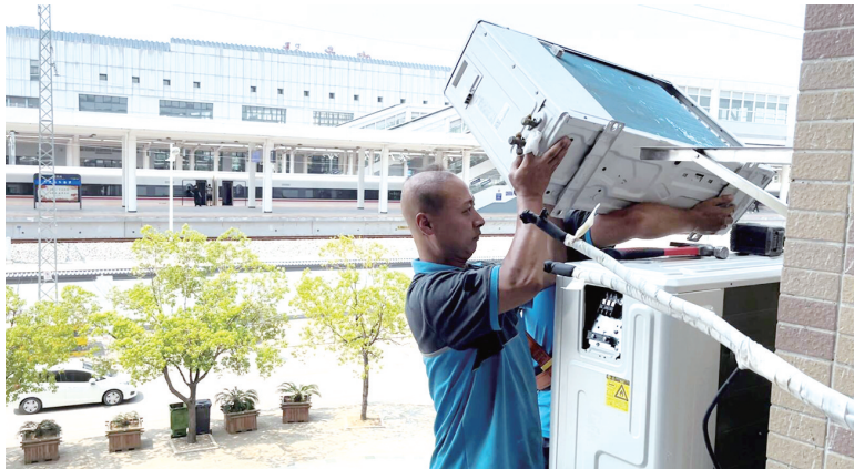
▲陈寅（左）和搭档正在安装空调外机。
