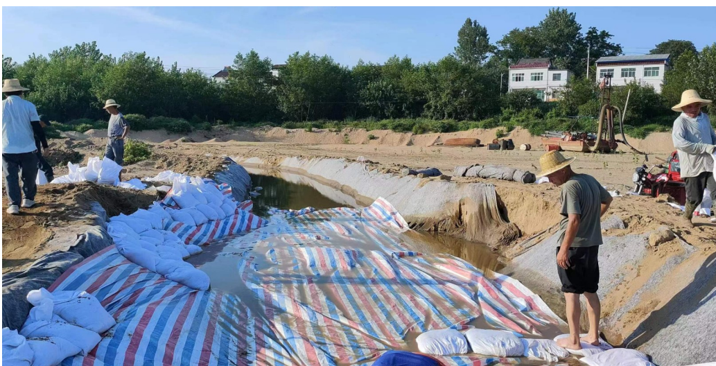
8月10日,黄龙镇干群在开挖蓄水池。
