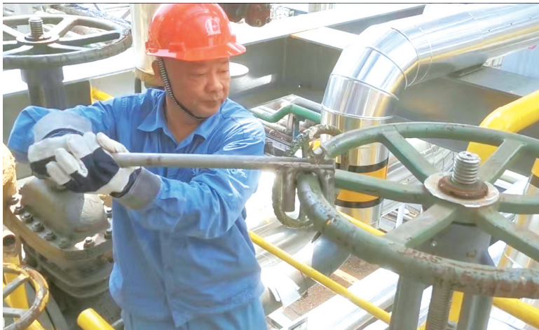
周卫民正在进行中压蒸汽吹扫打靶工作。图片由受访者提供
