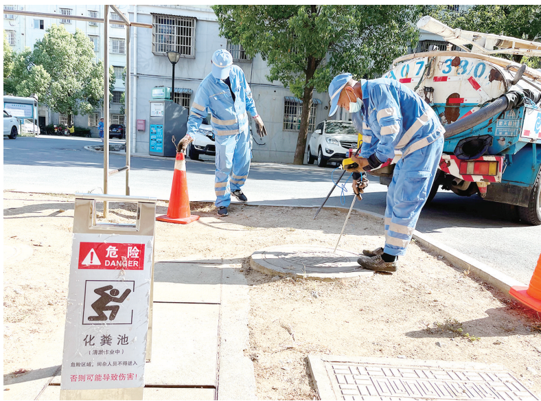
夏荣根在测量化粪池内甲烷值。
