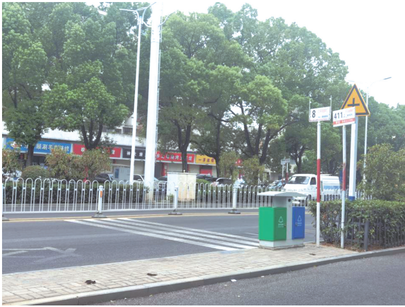
图为天柱山西路一拆除未安装的站亭
