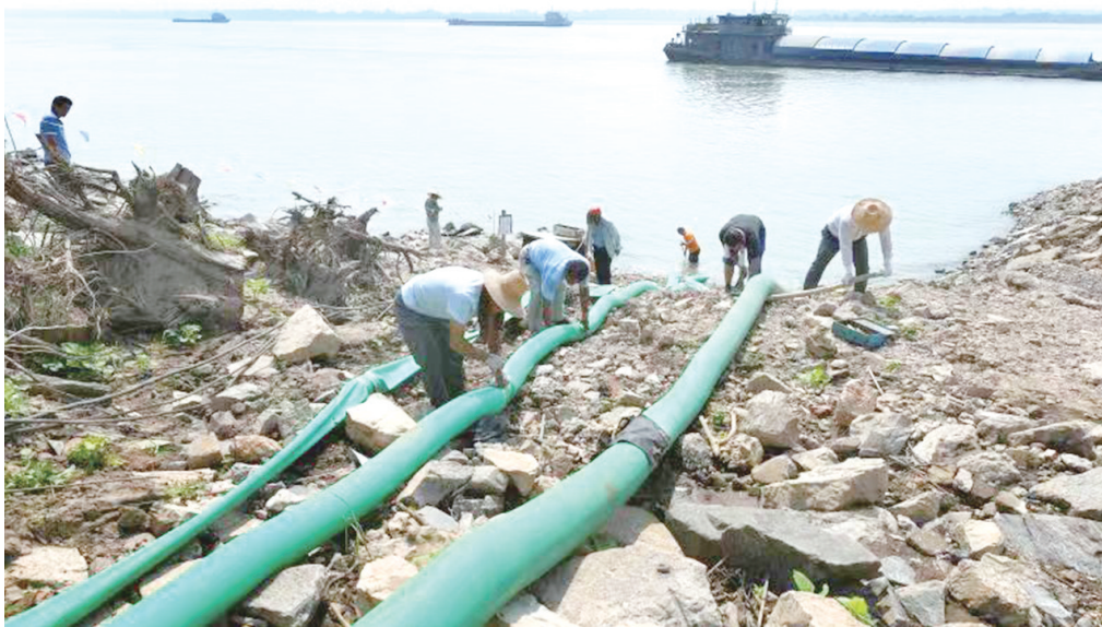
8月26日，在大观区海口镇海口村跃进圩，水利抗旱队员们在长江岸边架设了三台临时泵站引水入圩，有效缓解万亩农田的旱情。
