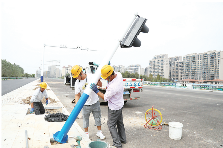
9月18日, 工人在滨江大道安装人行灯。
