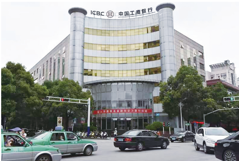
中国工商银行安庆分行大楼。
