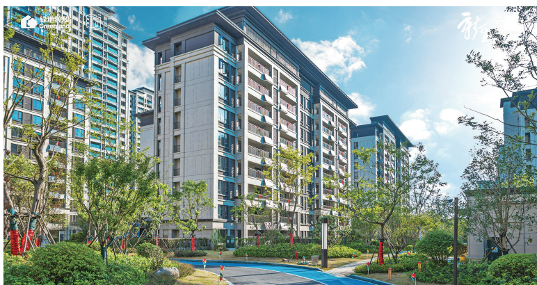
安庆绿地新里城一期翰林公馆洋房区交付实拍图。
