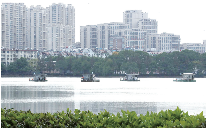
四艘洗脱船正在水面缓慢移动，把湖底淤泥吸到船舱内。
