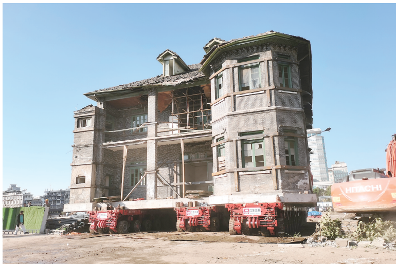
技术单位采用SPMT车载系统对整栋建筑实施平移。
