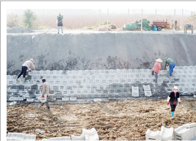
11月9日,望江县赛口镇十里长河万全段综合治理项目现场,施工人员正利用枯水期,加紧对长河两岸边坡进行砼预制块护砌,建设生态护坡。 生态护坡总长度0.79千米,预计投入200万元,工期将持续到今年年底,该项目通过“以工代赈”方式吸纳了当地60多人就业,工程竣工后将对赛口镇来年的农业生产、防汛抗旱等提供有力的保障。 全媒体记者 储永志 通讯员 陈娅 摄
