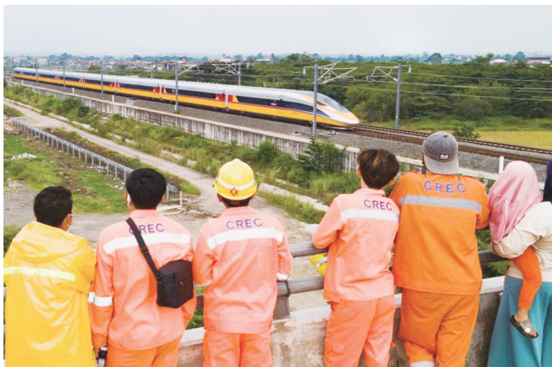
16日,在印度尼西亚万隆,雅万高铁建设者和当地民众观看高速铁路综合检测车行驶在雅万高铁试验段(无人机照片)。新华社发
