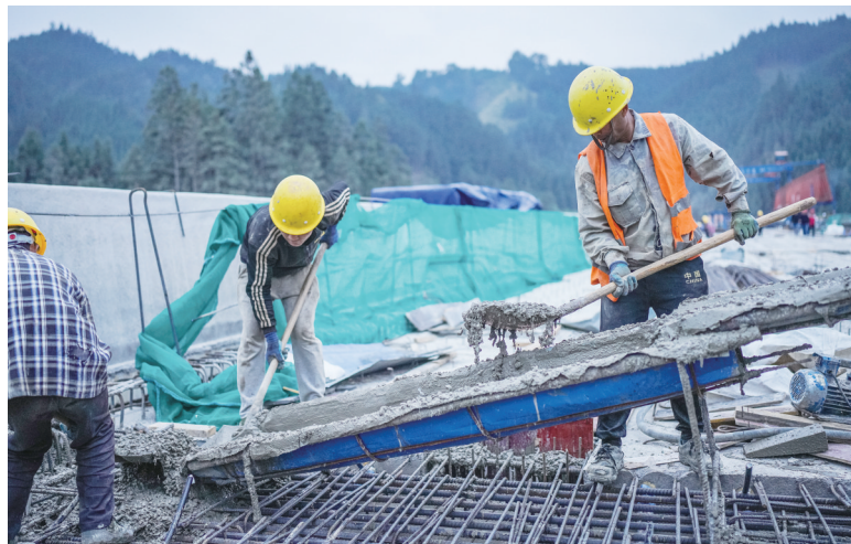
11月16日，贵州雷山至榕江高速公路建设项目在确保安全的前提下，正加紧施工，抢抓项目建设进度。 新华社 发
