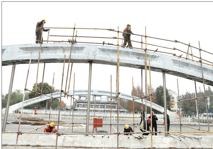
12月8日,龙眠山路新河桥因更换吊杆全幅封闭施工。
