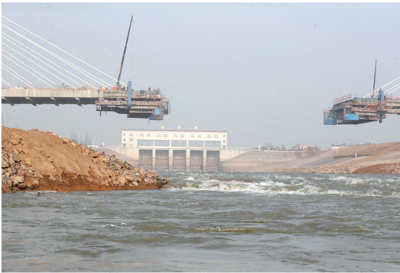
1月11日,望江县杨湾镇杨湾河特大桥大、小桩号引桥架设完成。预计2023年1月完成主桥合龙,5月正式通车。
